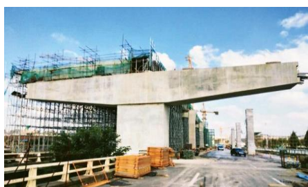
图 1-a 单柱墩预应力盖梁
