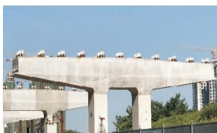
图 1-b 双柱墩预应力盖梁
