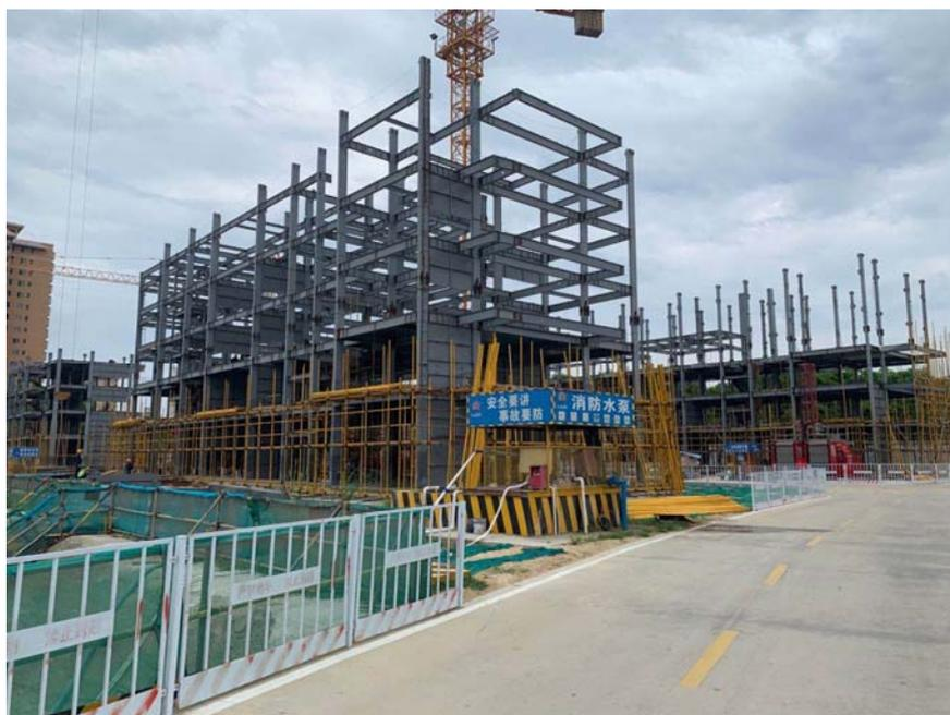
图 2 隐式钢管混凝土结构体系实拍图
