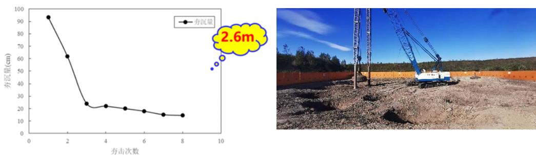
图 3 夯击次数-夯沉量关系图（左）及单点夯击现场图（右）
