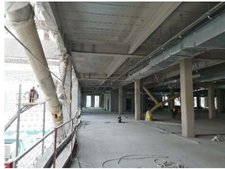
图 9 增幅机构连接黏滞阻尼器现场照片
