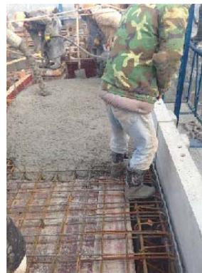
图6 现场浇筑再生混凝土
