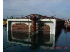
E10管節待二次澆築混凝土
