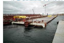
E10管節完成二次澆築混凝土
