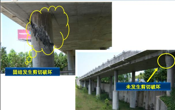
**固结发生剪切破坏**
