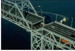
Loma prieta地震：奥克兰海湾大桥过渡孔落梁：低估了相对位移，连接螺栓剪断。
